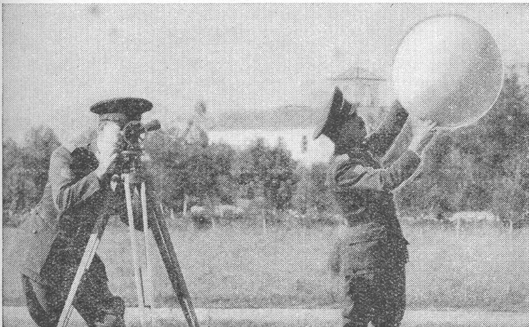
FIG. 208. — Globo piloto y teodolito aerológico, empleado para fijar su trayectoria, una vez lanzado al espacio.
