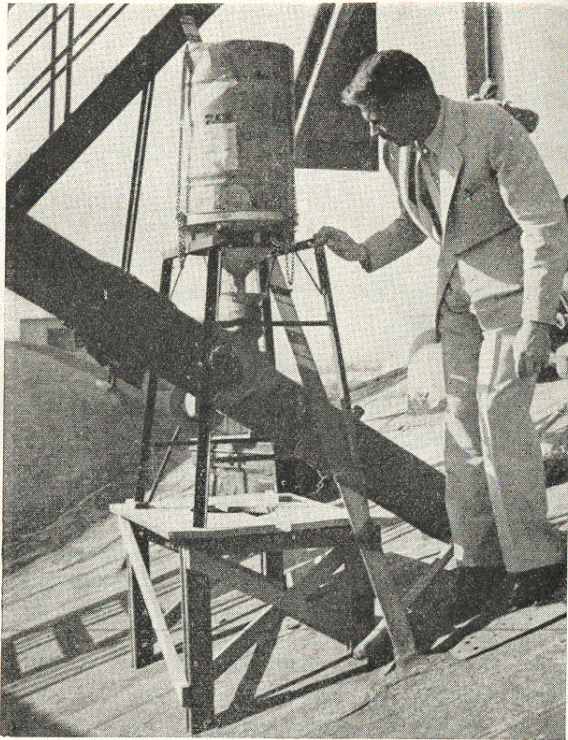
Fig. 214. — Vista del tambor con cianuro de calcio, del cual sale el fumigante para mezclarse con la corriente de grano que pasa por el tubo de carga del silo. (Foto LÓPEZ).
